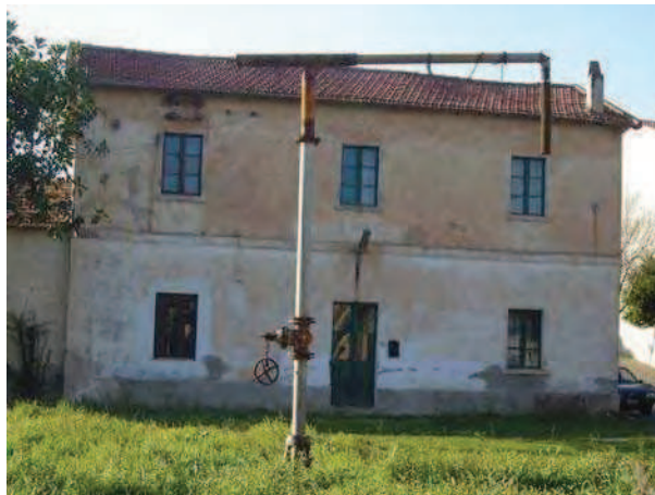
Prospetto della stazione ferroviaria
