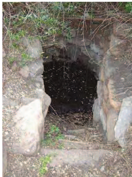
Particolare della camera del pozzo
