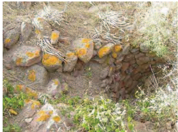
Particolare camera torre laterale
