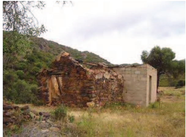
Particolare di un edificio in lastre di scisto con ampliamento in blocchetti
