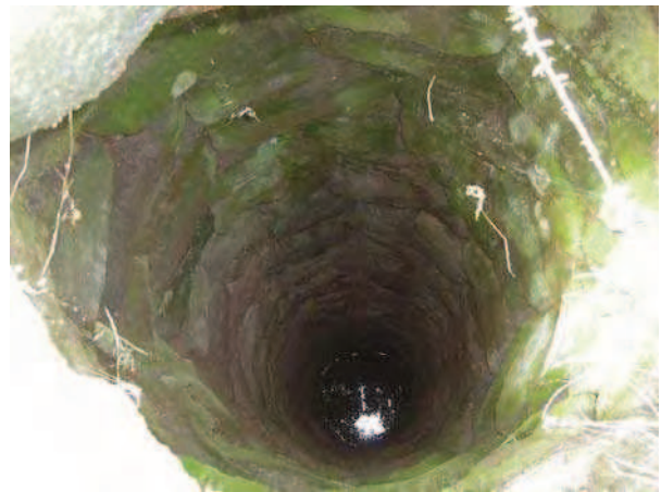
Interno del pozzo
