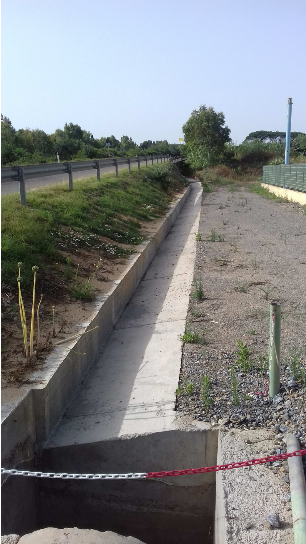
Fotografia n.10 – vista delle opere di raccolta e smaltimento delle acque bianche esistente
